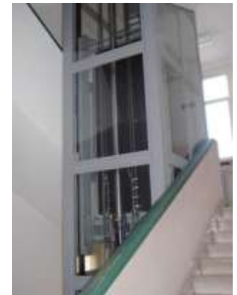
corpo scala con ascensore
